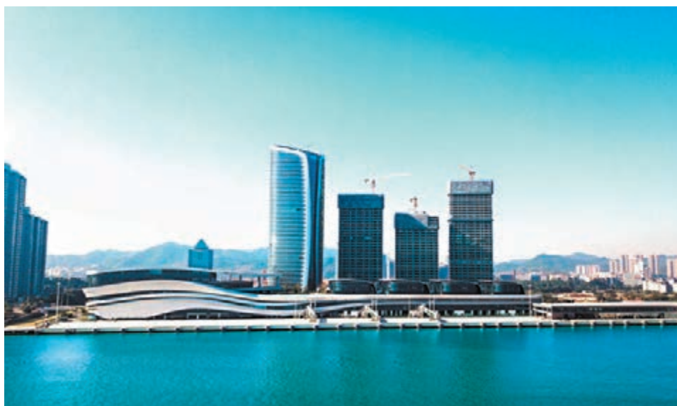
●廣州南沙國際郵輪碼頭工程全面通過竣工驗收。
