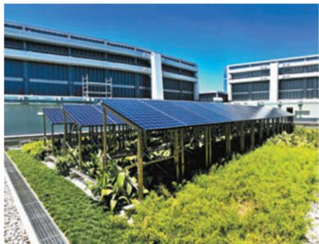
太古坊1座天台共安裝約170塊太陽能板，可提供整座大廈約1%的電量。
