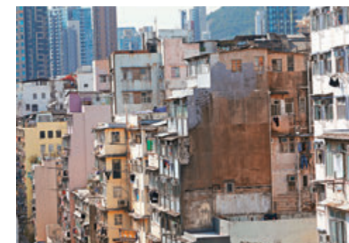
●斜面樓是「街影法」的產物，多集中於上環、灣仔、深水埗、油麻地一帶，圖為深水埗的斜面樓。香港文匯報記者 攝
