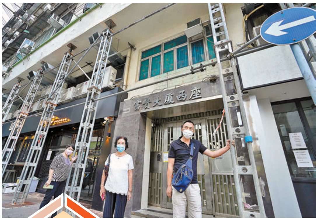
▲位於大角咀的富貴大廈分為東西兩幢，樓齡均逾60年，被屋宇署列為危樓，樓宇四周圍需用鐵架支撐。住戶廖太(左)和李女士(中)表示，支持政府調低舊樓強拍門檻。
