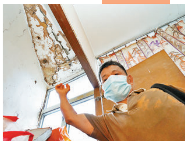
●業主王先生單位內的天花石屎剝落，露出生鏽鋼筋。
