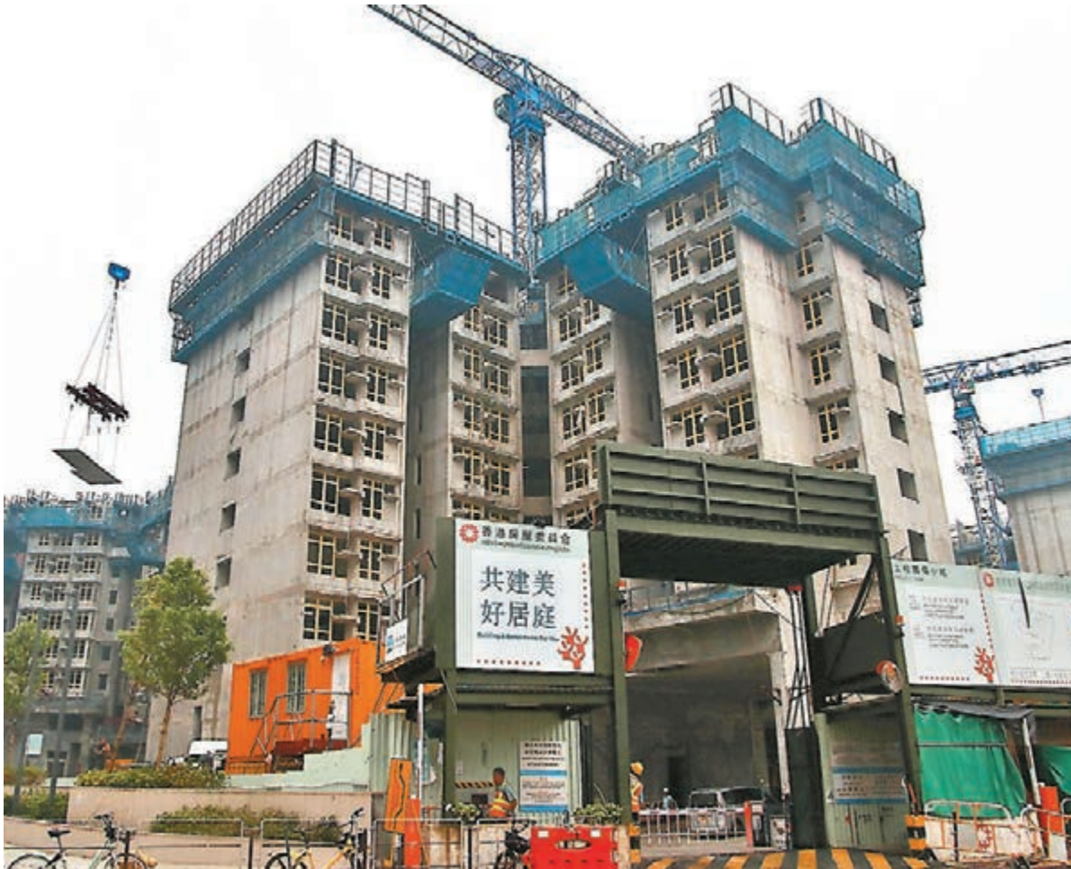
●林鄭月娥正構思若房委會建屋慢，須代特區政府向輪候公屋的市民付現金津貼。圖為興建中的公營房屋。資料圖片
