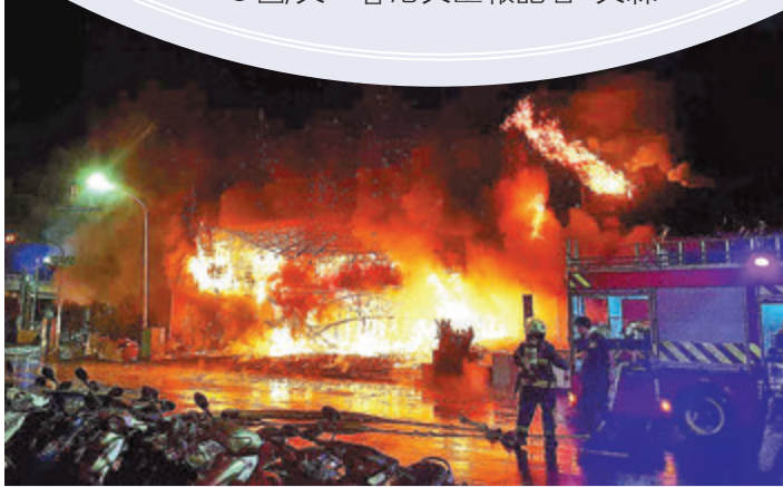
●台灣高雄市樓齡超過40年的「城中城」大樓14日發生奪命大火，敲響本港舊樓警鐘。
