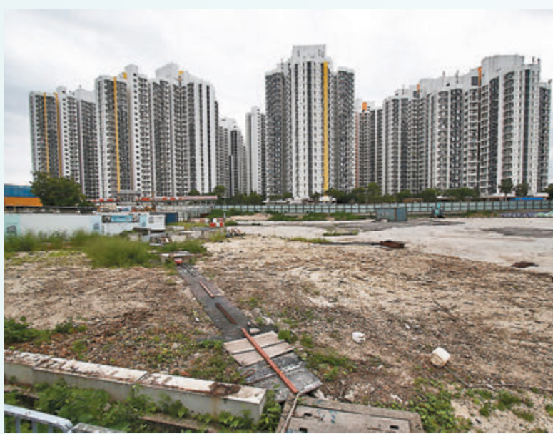
●洪水橋的安置屋邨地盤仍未動工，劉國勳指政府部門各自為政影響收地進度。 香港文匯報記者 攝
