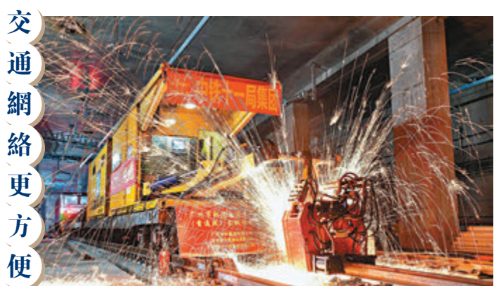
●廣州地鐵18號線開通。圖為焊接該線鋼軌接頭。 新華社
