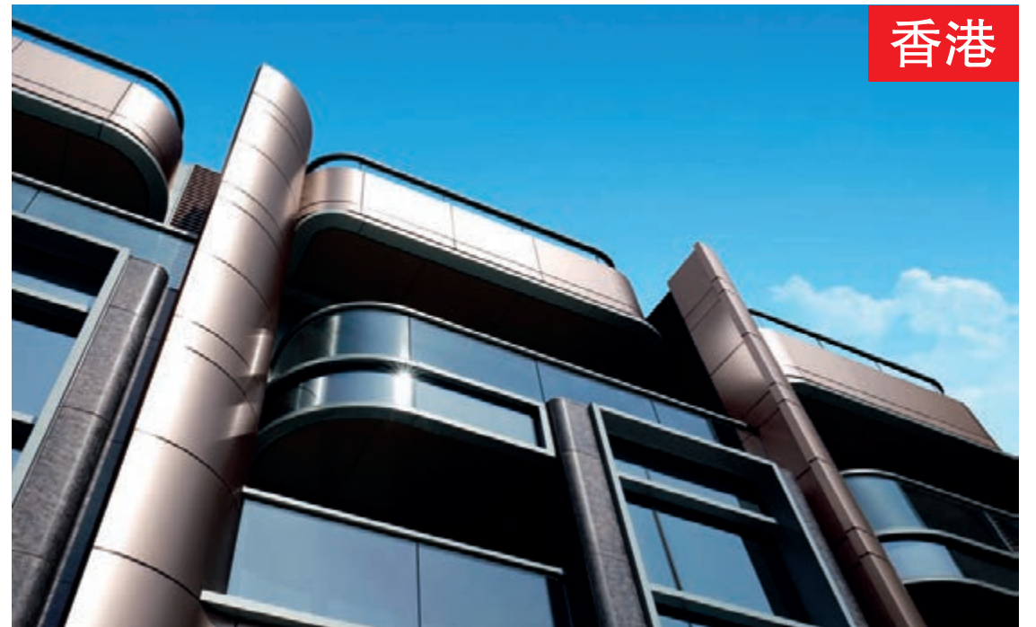
● 全新豪宅項目「嘉琳」由5個庭院洋房單位組成，每個單位面積逾4000平方呎。項目採用有「太空金屬」美譽的鈦金屬打造獨特的外立面。
