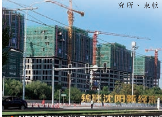
創新路旁錦聯科技園正在為多家科技公司建設辦公樓。
