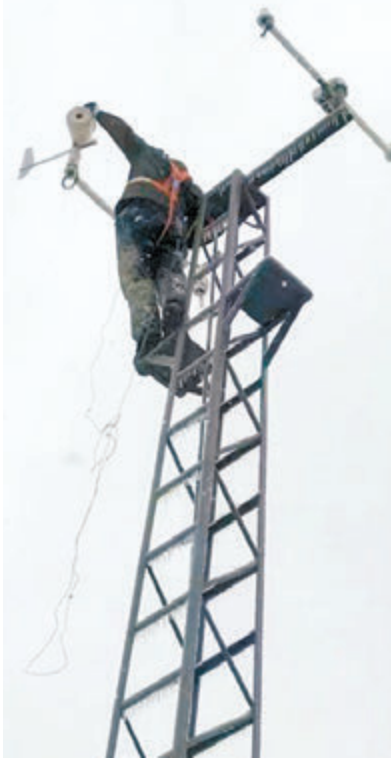
●鞍山岫巖氣象觀測站工作人員對觀測站風杯進行除冰。受訪者供图
