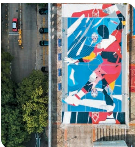
●屯門H.A.N.D.S上蓋籃球場完成翻新工程後的鳥瞰圖。
