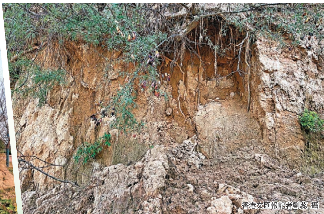
暴雨後——漢霸二王城所在山體坍塌
