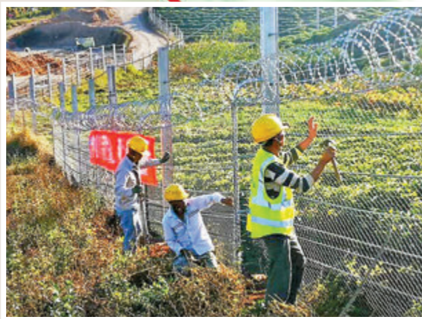
●設置隔離欄，防止野象被傷。中鐵昆明局集團供圖
