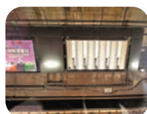
●鋼鑼灣港鐵站行車隧道肇事廣告箱已拆除。香港文匯報記者 攝
