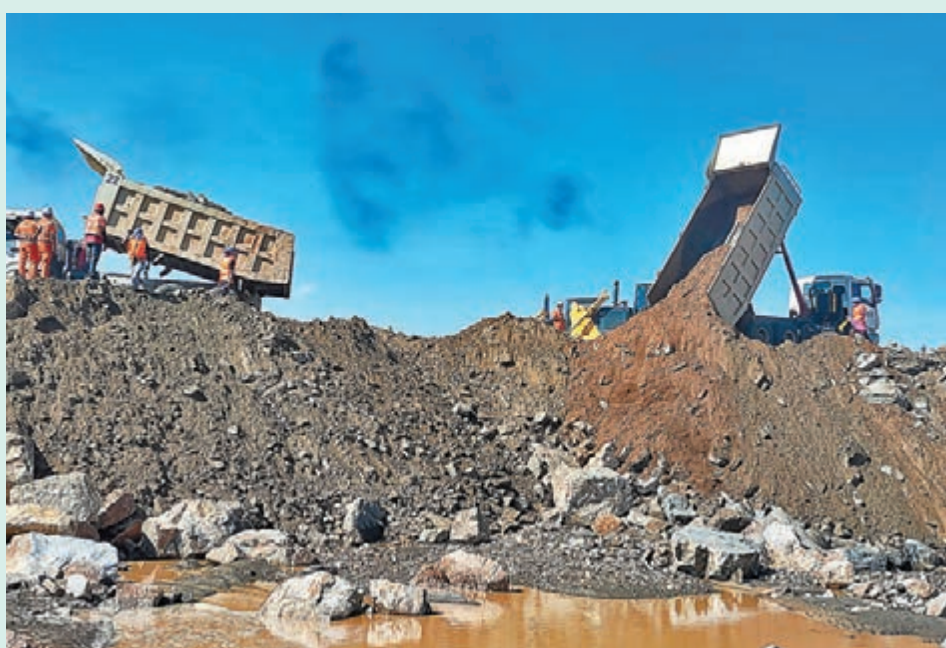
◆中國在非洲之角將發揮積極建設性作用。圖為中企承建的肯尼亞斯瓦克大壩工程成功截流。新華社
