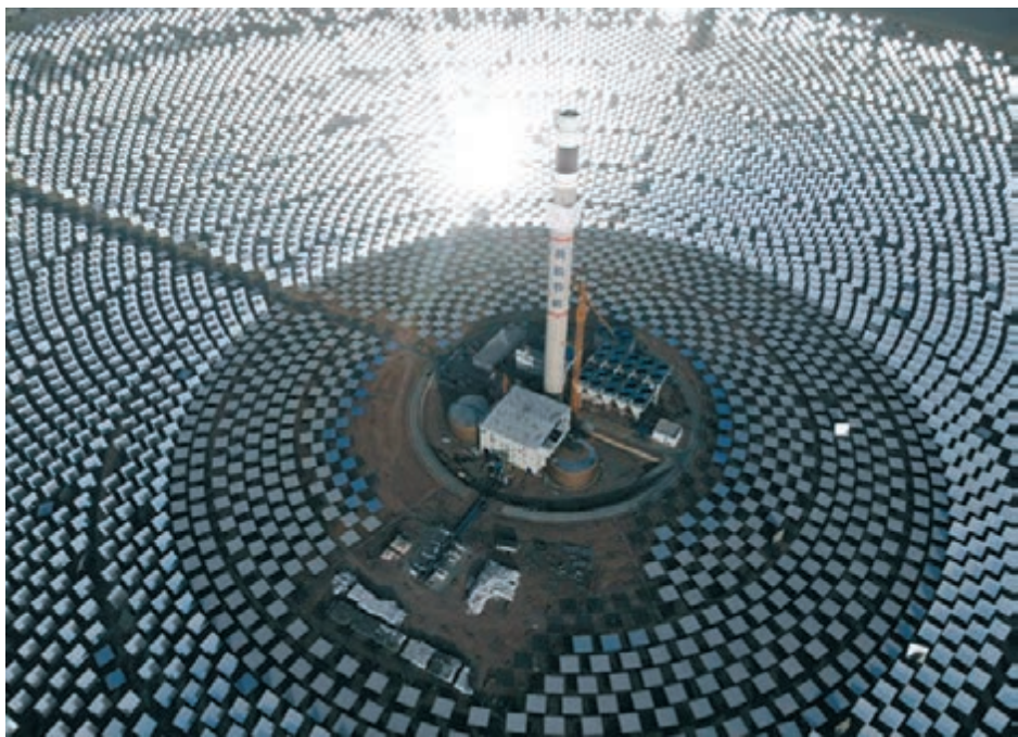
◆ 敦煌光熱發電站地處戈壁灘，科幻感十足，是該城的新地標。而從高角度可見，光熱發電的吸熱塔和其他設備，設在一圈圈巨鏡的中心。
