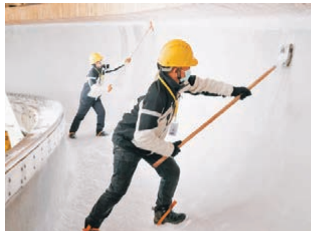
◆製作延慶國家雪車雪橇中心賽道難度高。圖為國家雪車雪橇中心，工人正在工作。資料圖片
