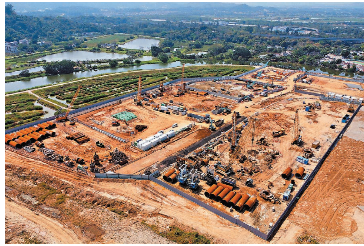
◆落馬洲河套區施工現場多輛工程車輛出入，起重機在忙碌地作業。
