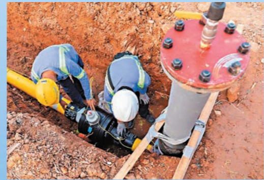
◆煤氣公司工作人員鋪設煤氣管線。
