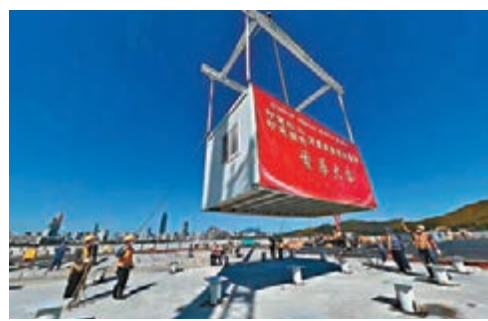
◆3月9日，工程人員完成了首個集成式箱體吊裝。
