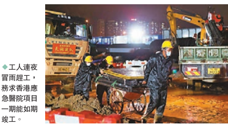
◆工人連夜冒雨趕工，務求香港應急醫院項目一期能如期竣工。
