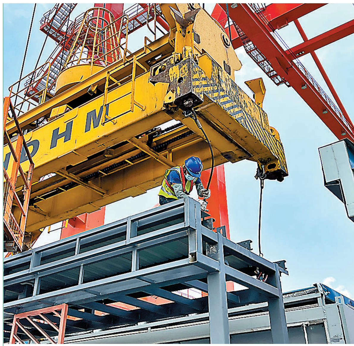
社區隔離設施模塊化集成房屋和方艙模塊都不是標準貨櫃尺寸，需要安排專人在現場掛上掛鉤，然後吊裝上船。香港文匯報記者黃寶儀攝
