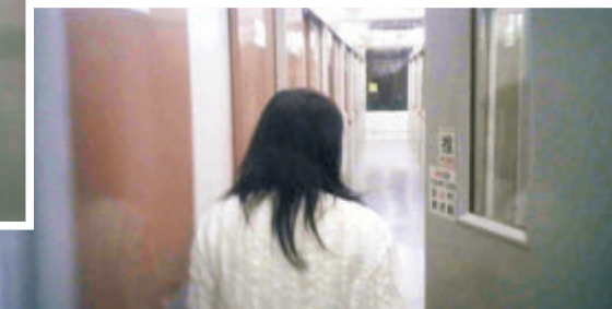
▼個別迷你倉的通道上方，並未懸掛安全出口的方向指示牌。香港文匯報記者 攝
