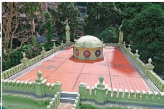
▲ 回教清真禮拜總堂禮拜殿屋頂的護牆以圓形城齒裝飾，每隔一段距離設有尖頂座敦。
