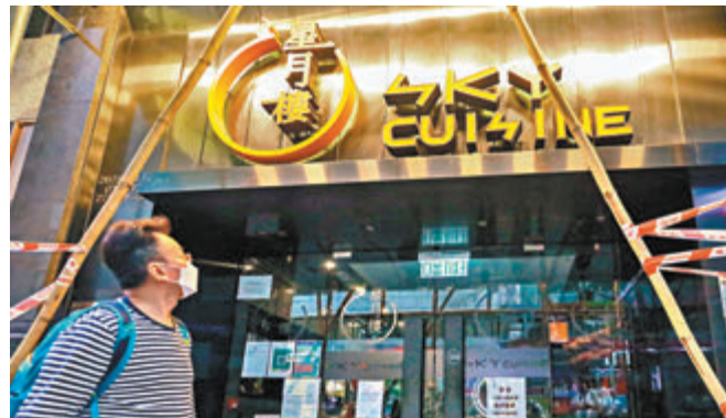
◆星月樓廁所抽風機錯誤反轉安裝，及鮮風機沒全開。資料圖片
