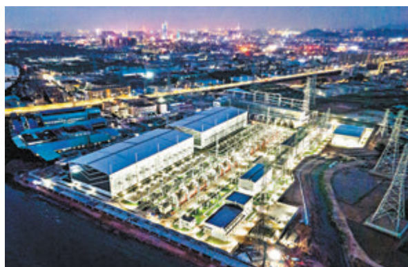
夜色中的粵港澳大灣區直流背靠背電網東莞工程。受訪者供圖
