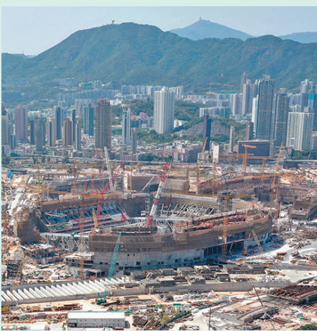
◆耗資約300億元的啟德體育園預期2023年年底陸續完工。
