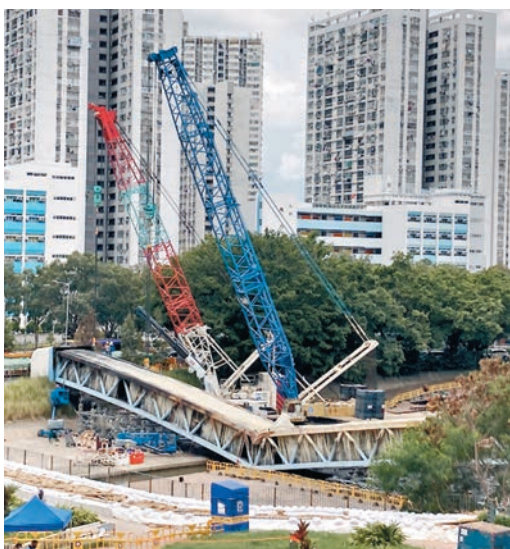
◆中電開始移除電纜橋，料一周內完成。香港文匯報記者攝
