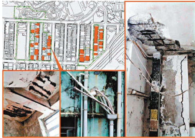
▲市建局於衙前圍道及啓德道的重建項目，其中一幢屬於第五級的舊樓，卻出現公用地方鋼筋外露、渠管亂取等情況。網誌圖片
