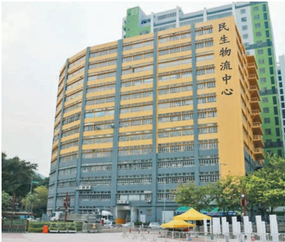
◆屯門民生物流中心位於屯門洪祥路3B號，地盤面積約3.6萬方呎，屬丙類地盤。
