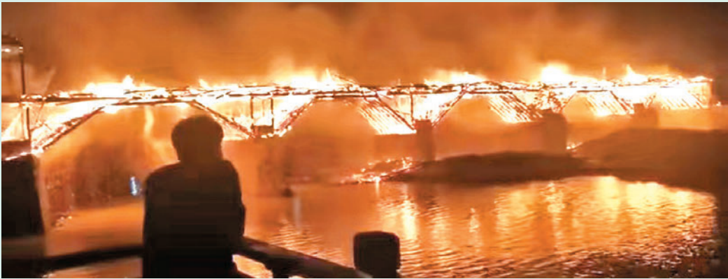
◆8月6日，位於福建寧德、中國現存最長木拱廊橋——萬安橋失火。圖為8月6日晚，萬安橋失火場景。
