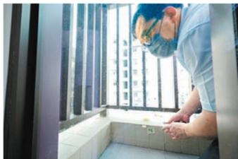
露台有8塊飾面磚出現空心磚，另外底飾面磚也有裂痕、掃口鏽縫及污跡等。
