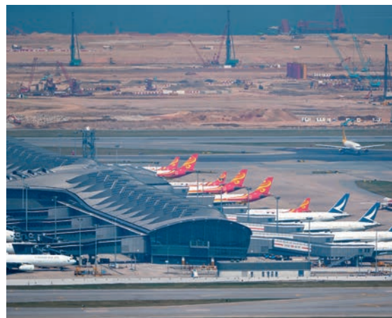
廉署拘30人疑涉三跑工程貪污。圖為香港國際機場第三跑道施工工地。
