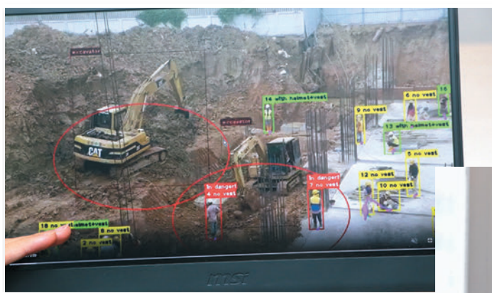
◆ 使用人工智能工地安全監察系統時，當有工人誤進「致命區」，就會觸發警報系統或者警報燈，系統亦會在工人頭上顯示紅色標誌。
