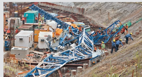
◆天秤壓毀多個貨櫃辦公室，天秤亦告嚴重扭曲變形。 香港文匯報記者攝
