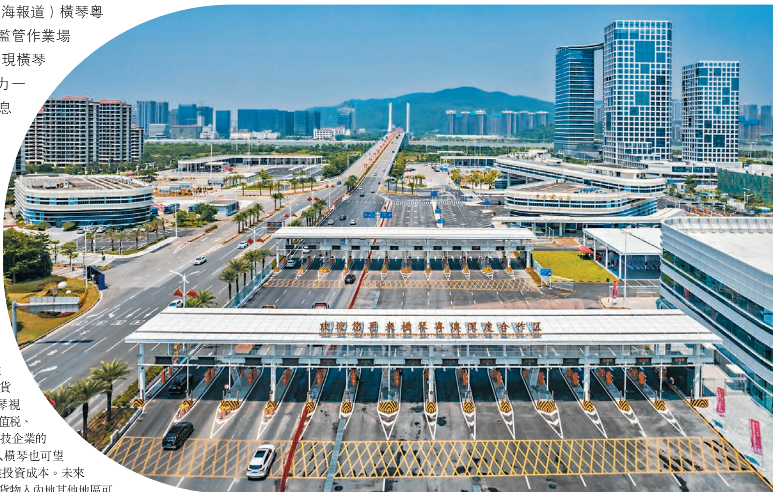
◆橫琴「二線」通道海關監管作業場所主體工程落成。
