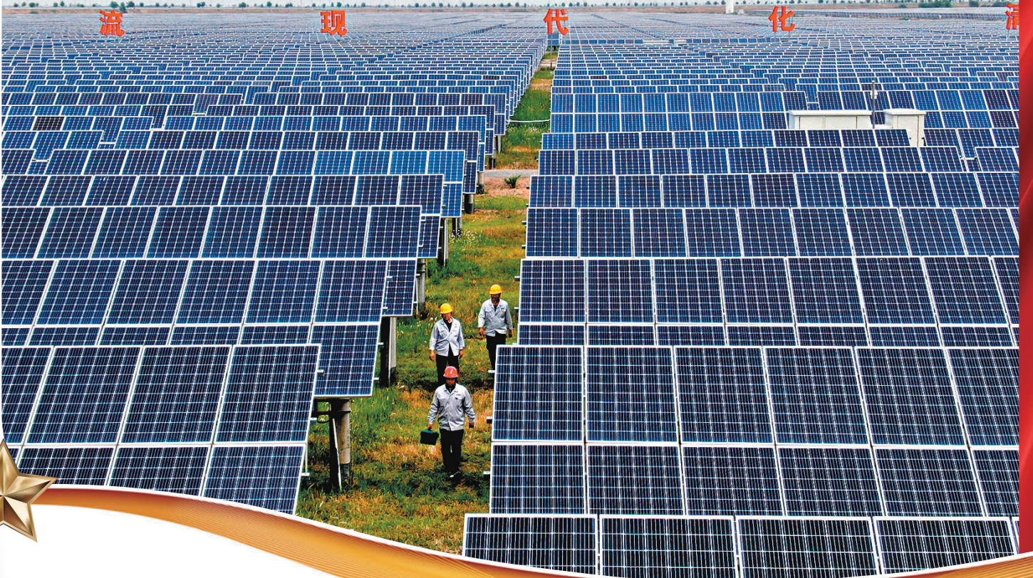
◆內地水電、風電、光伏、生物質發電裝機規模和在建核電規模穩居世界第一。圖為山東省濱州市沾化區富源街道的華能沾化清風湖風光同場項目區，工人們進行光伏電站的日常巡檢。資料圖片
