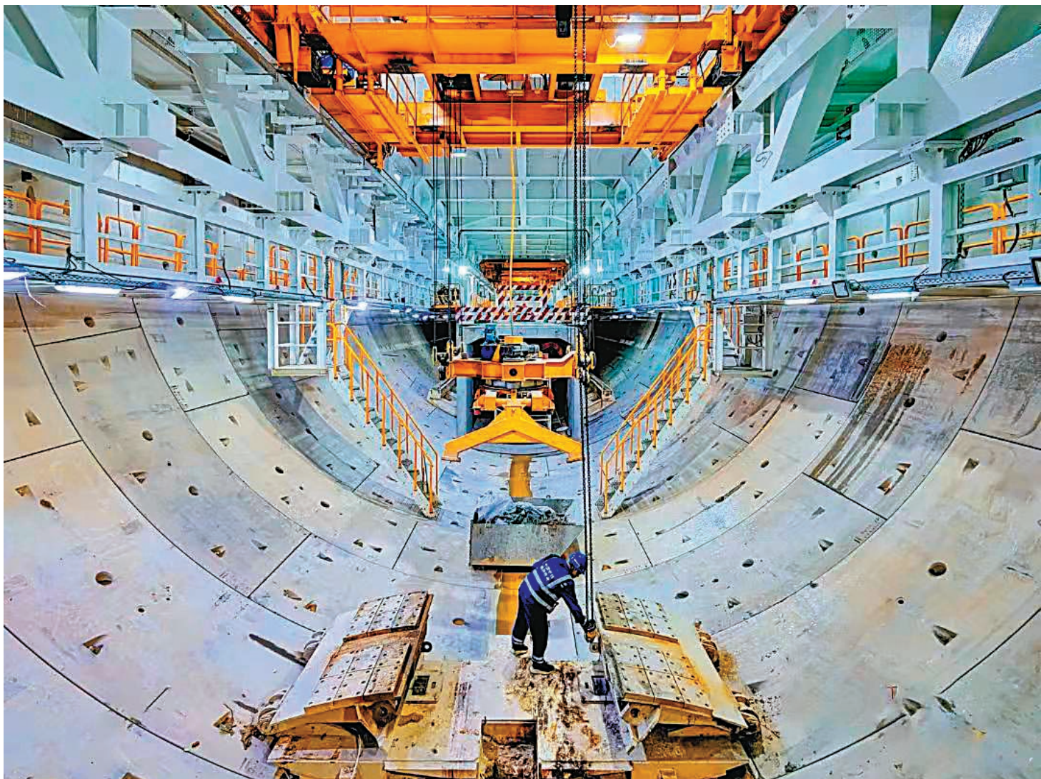
◆媽灣跨海通道作為國內在建最大水下盾構工程，施工過程中面臨了諸多挑戰。圖為項目工作人員正在進行工作。
