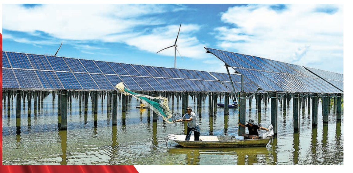
▼中國能源生產使用調整優化。圖為建設在魚塘上的光伏電站。資料圖片
