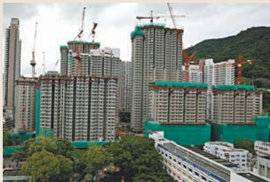
議員冀政府修例加快土地開發。圖為興建中的公營房屋。資料圖片
