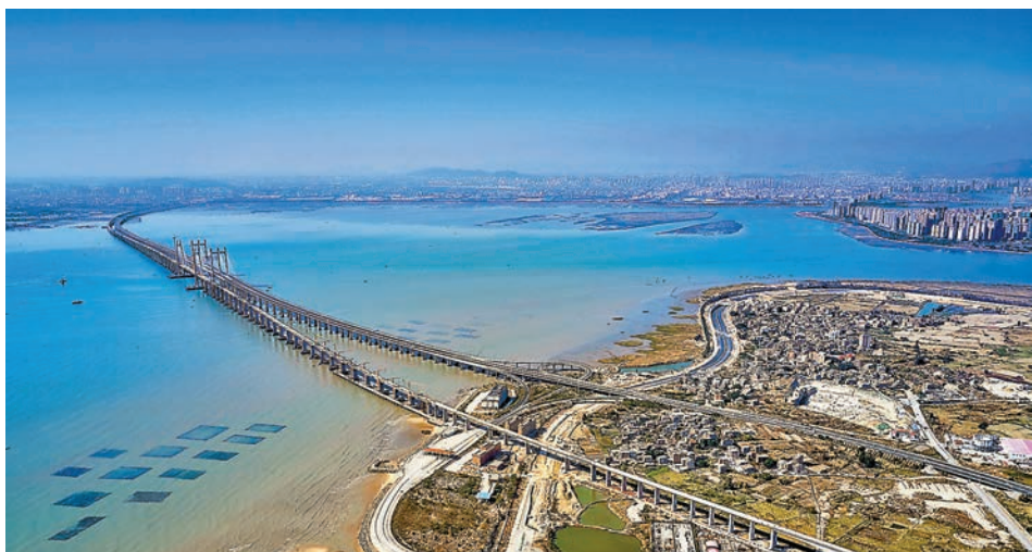
◆福廈高鐵在跨海大橋技術上的突破，代表中國鐵路橋樑的飛躍。
