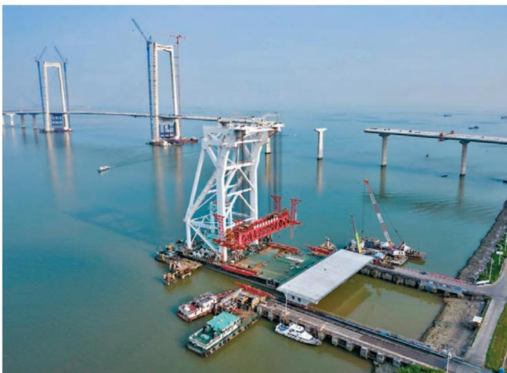
◆10月8日，廣東省中山市，一片混凝土箱樑準備運送上運架一體船「天一號」。當日，隨着第155片60米混凝土箱樑預製完成，粵港澳大灣區核心工程深中通道混凝土箱樑全部預製完成。 資料圖片
