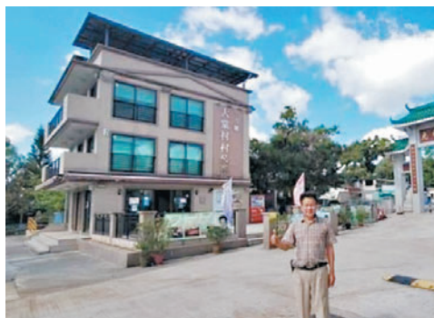
◆梁福元表示，大棠村村公所天台安裝太陽能板後，每月電費最多慳到一半。受訪者供圖
