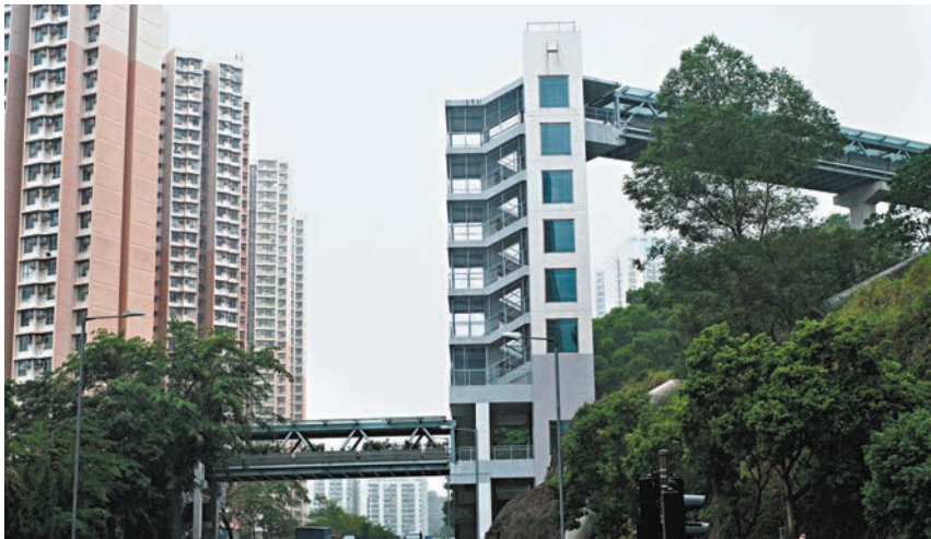
◆審計署報告指出，土木工程拓展署在安達臣道行人天橋設計仍未敲定就進行招標，之後要大幅改動3條天橋設計，並要多建第四條天橋，以致整項工程最後埋單超支近10億元。 香港文匯報記者涂穴 攝
