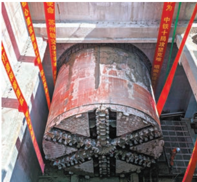
◆中國盾構機保有量大概3,300台。圖為盾構機在軌道交通工程中成功出洞。 資料圖片
