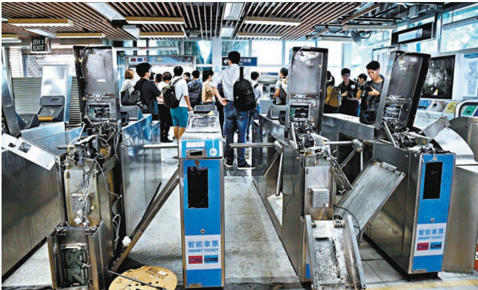
◆修例風波期間港鐵設備不時遭暴徒大肆破壞。圖為2019年11月18日大學站內入閘機遭破壞。
