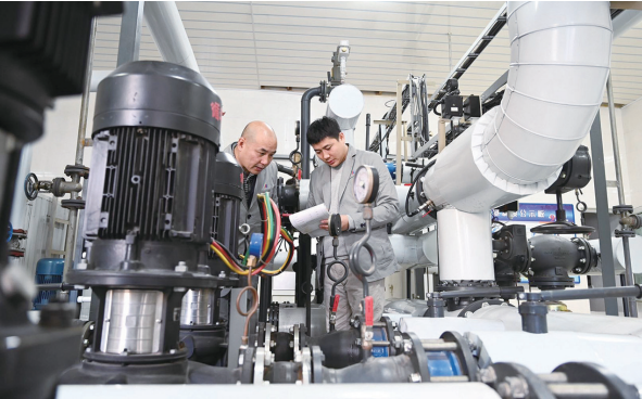
◆春城熱力維修工人檢查泵站設備。
