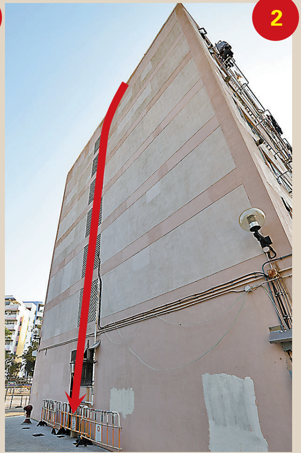
◆疑犯由漁安樓7樓天台墮下。
