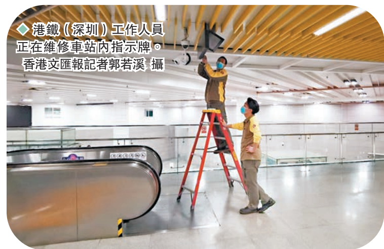
◆港鐵(深圳)工作人員正在維修車站內指示牌。香港文匯報記者郭若溪攝
