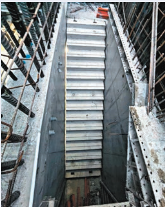
◀恒地近年實行「無木建造」，以鋁模板代替木模板。圖為以裝配式設計方法建造的樓梯。
