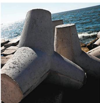
◆ 混凝土俗稱「石屎」，主要由碎石、水泥和水，再加上適當的化學添加劑混合而成。圖為混凝土防浪構件。 資料圖片
